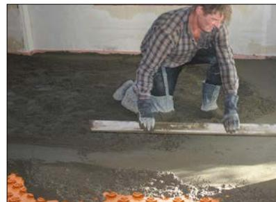
**13.** Abziehen der Estrichfläche mit einer Mindestüberdeckung von 8 mm. Höhenausgleich bei bereichsweisen Unebenheiten bis max. 15 mm Estrichüberdeckung (für nichtkeramische Beläge Datenblatt 9.7 beachten).
