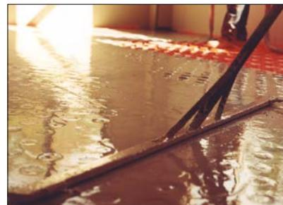
**14.** Alternativ zu **12.** und **13.**: Einbringen eines Fließestrichs: Sorgfältige Verlegung der Noppenplatten und Verschluss der Schnittkanten/Endpunkte. Ein Hinterlaufen der BEKOTEC-Platten ist zu verhindern.
