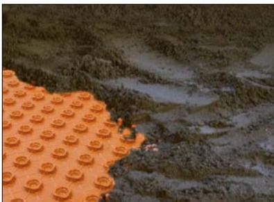
**12.** Einbau des Estrichmörtels ohne Bewehrung und Bewegungsfuge (Estrichgüte CA/CT-C25-F4, max. F5). Ausnahme: im Türbereich, mit Kellenschnitt oder Dehnfugenprofil Schlüter-DILEX-DFP sowie bei Bauwerkstrennfugen.
